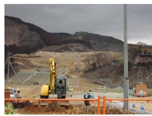
・高台移転地 工事が進む高台造成地
