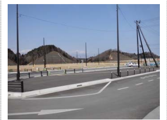
・東名駅前高台移転地 ほぼ工事が終わっているが 何人が移転して来るのか、 海は見えない
